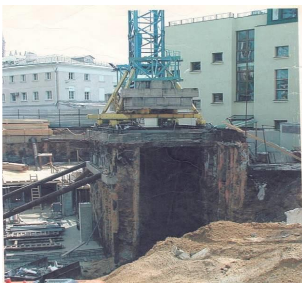
Сл. 8 Торањска дизалица ROTAIN 646 G на железничким шинама монтираних за металне широке I профиле ослоњене преко бетонских греда на металне шипове
