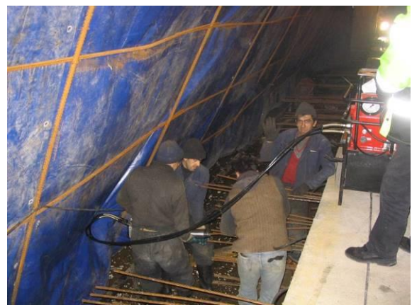
Слика 10. Рад у зимском периоду ,обезбеђење температуре калориферима од 10°C ради обављања преднапрезања
