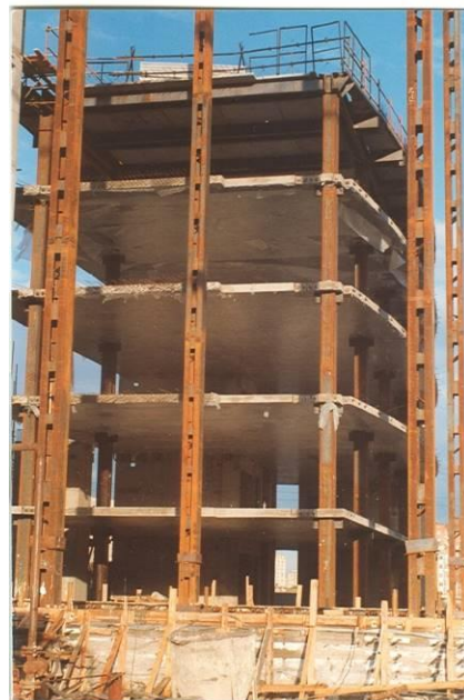
Слика 6. Међуспратне преднапрегнуте плоче постављене у коначни положај
