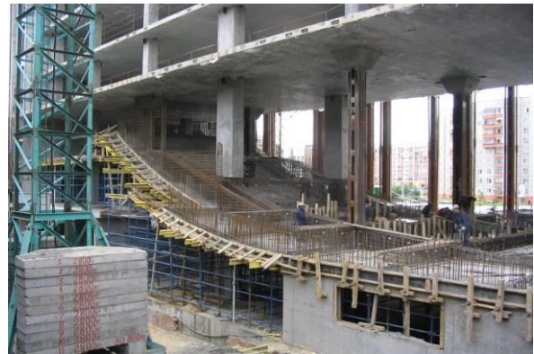
Слика 11. Формирање носеће конструкције свечане сале, испод подигнутих плоча
