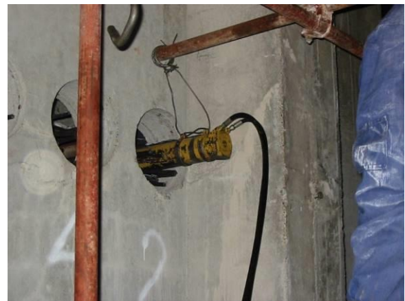
Слика 24. Фаза преднапрезања каблова са пресом ИМС за појединачно утезање
