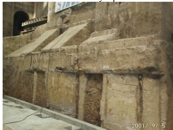
Слика 21. Темељи централних звоника променљиве геометрије и крутости види се и нова темељна плоча крипте
