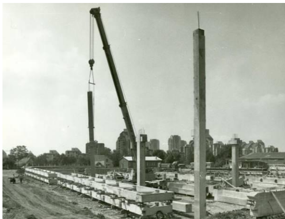
Слика 5. Монтажа стубова са уграђеним на врху, за везу са кровном решетком
