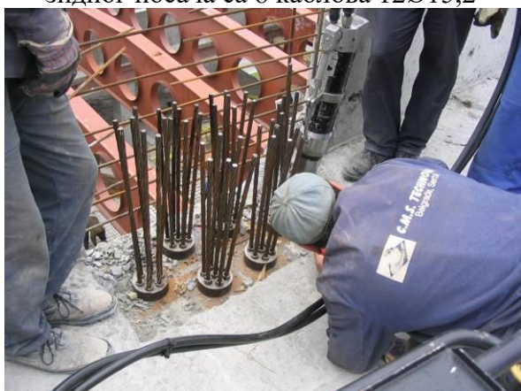
Слика 14. Завршна фаза вертикално преднапрегнутих стубова
