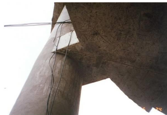
Слика 14. Веза угаоног стуба и међуспратне таванице по првобиноме
