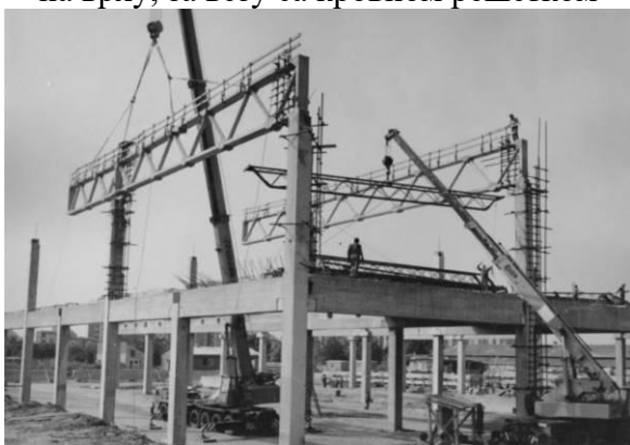
Слика 6. Монтажу главне кровне решетке, прати монтажа кровне роњаче
