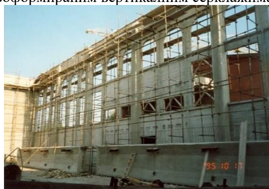
Слика 9. Изведени арм. бетонски фасадни зидови, са постављеним трасама каблова у горњем делу зида
