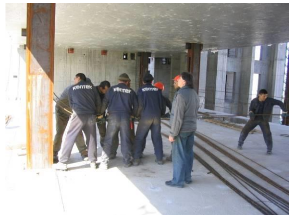
Слика 12. Убацивање каблова 6\varnothing 15,2 у стубове одоздо нагоре за формирање затеге
