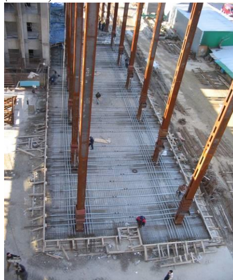
Слика 7. Формирање трасе каблова за преднапрезање
