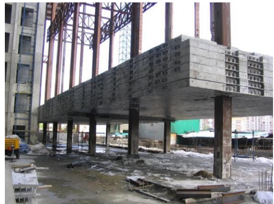
Слика 9. Почетак подизања једног од 6 пакета, тежине 1850 тона, који је окачен о челичне вешалке којима се обавља крупна монтажа
