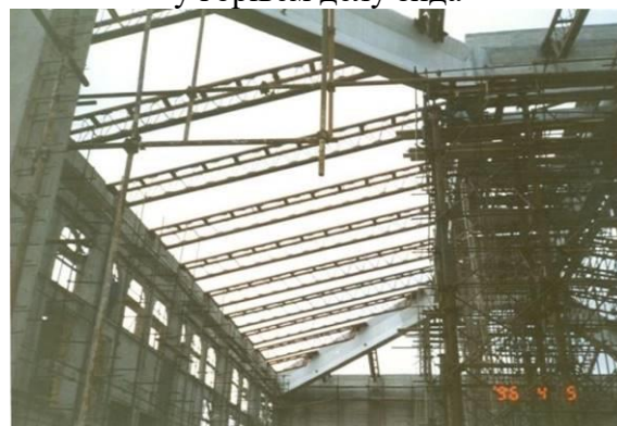
Слика 10. Кровна конструкција ослоњена на централну скелу и зидове
