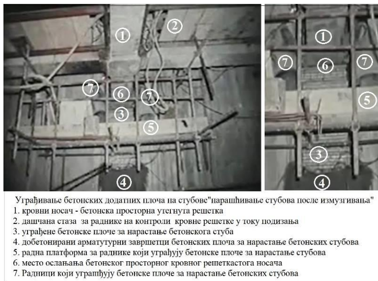
Слика 14. Нарашћивање бетонских стубова убацавањем бетонских плоча намењених за то
