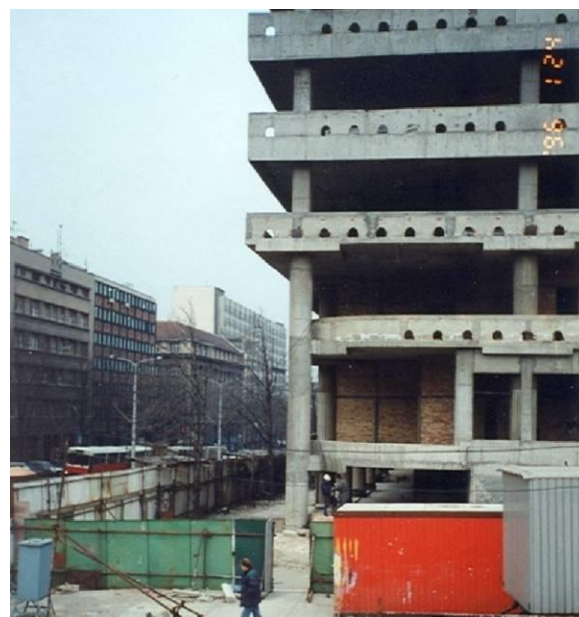
Слика 11. Изглед конструкције НБЈ са угаоним стубом
