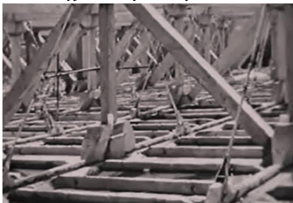
Слика 7. Носач крова -Бетонска утегнута просторна решетка висине 3,7 м пре подизања
