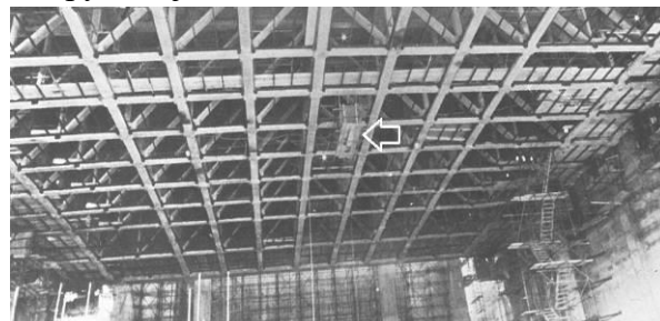
Слика 8. Поглед одоздо на кровну бетонску просторну решетку, приликом подизања -стрелицом је означено радно место у центру крову руководиоца операције подизања
