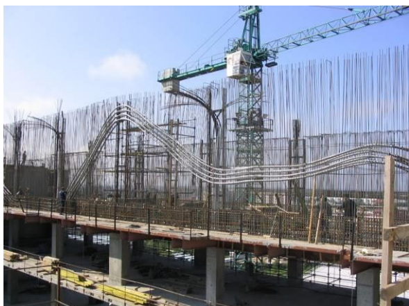
Слика 13. Постављање трасе каблова зидног носача са 8 каблова 12Ø15,2
