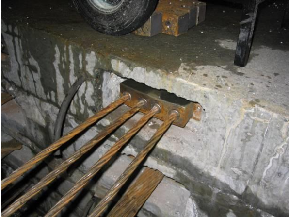
Слика 8. Котва попречних плъоснатих каблова
