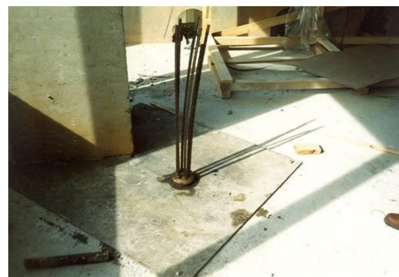
Слика 12. Котвљење каблова са горње стране затеге
