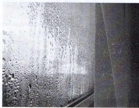
Slika 2. Kondenzacioni proces na zastakljenju proizvoda
