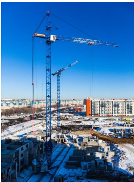
Сл.13 Торањски кран на шинском колосеку
