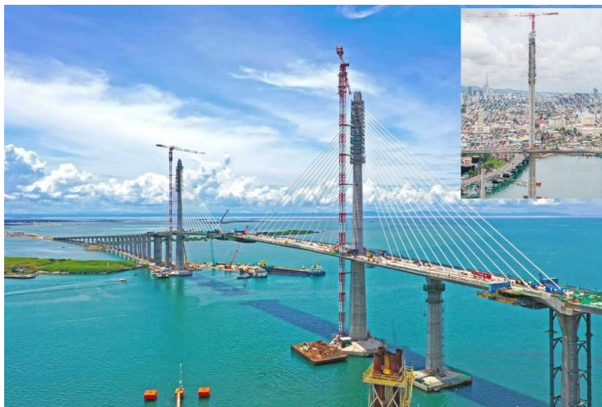
Сл.15 Торањски кран са равном стрелом COMANSA 21 LC660 на изградњи моста
