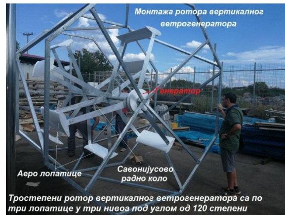
Слика 19. Монтажа роторнога блока ветрогенератора
