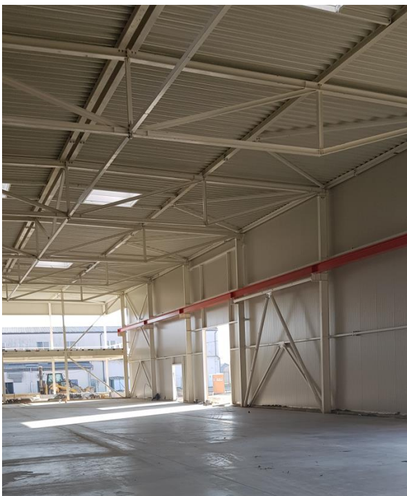
Слика 6. Изглед хале са приказаним делом уграђених врата и кранском стазом
