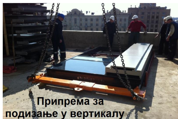
Слика 10. Фасадни панел спреман за подизање и вертикални транспорт до места уградње
