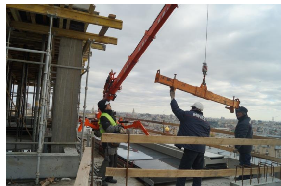
Слика 27. Веома тесни услови за монтажу, а тежина фасадног панела износи око 600 kg
