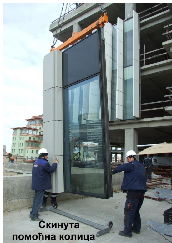
Слика 13. – 14.. Демонтирање помоћних колица
