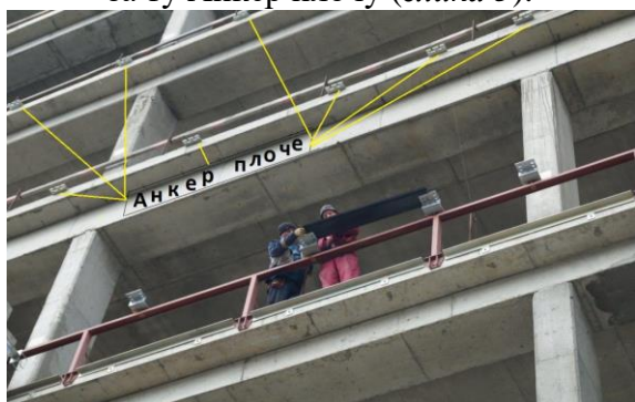
Слика 5. Намонтиране Анкер металне плоче на бетонским спратовима
