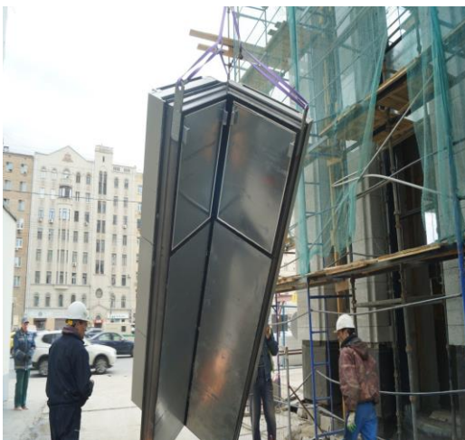
Слика 33. Подизање и монтажа угаоних фасадних панела са спрата висине 65m
