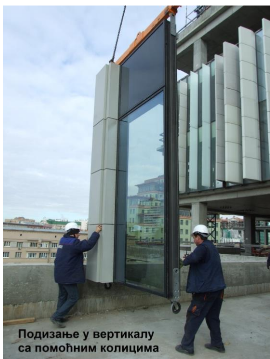
Слика 11. – 12. Постепено исправљање фасадног панела и уклањање металног рама
