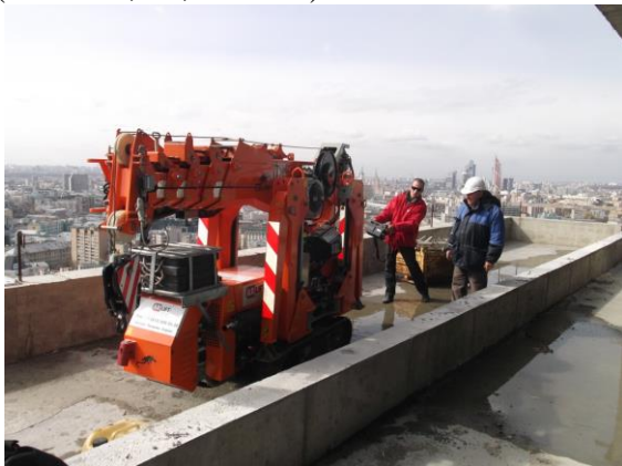
Слика 22. Премештање гусеничног крана по уском коридору терасе зграде
