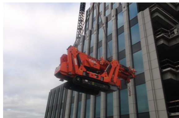
Слика 21. Пренос малог гусеничног крана на место монтаже са великим торањским краном
