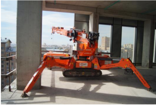
Слика 32. Подизање и монтажа угаоних фасадних панела са 14. спрата зграде
