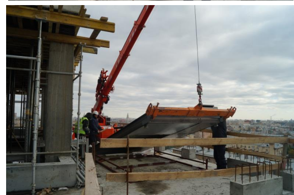
Слика 28. Обезбеђивање и подизање тешког фасадног панела
