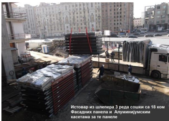
Слика 7. Истовар скупине фасадних панела са торањским краном из Џамбо шлепера
