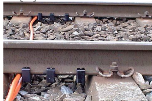
Слика 18. Постављени фибер оптички сензори на колосек [39]
