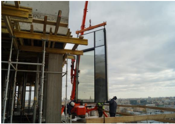
Слика 29. Фасадни панел је три пута већи од малог гусеничног крана
