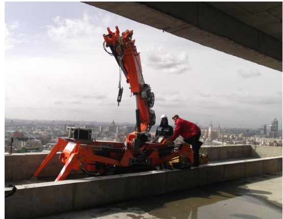
Слика 24. Припрема за рад малог гусеничног крана
