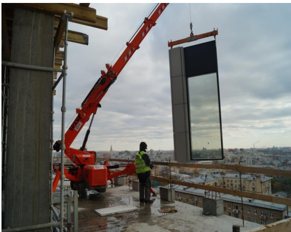
Слика 29. Фасадни панел је три пута већи од малог гусеничног крана
