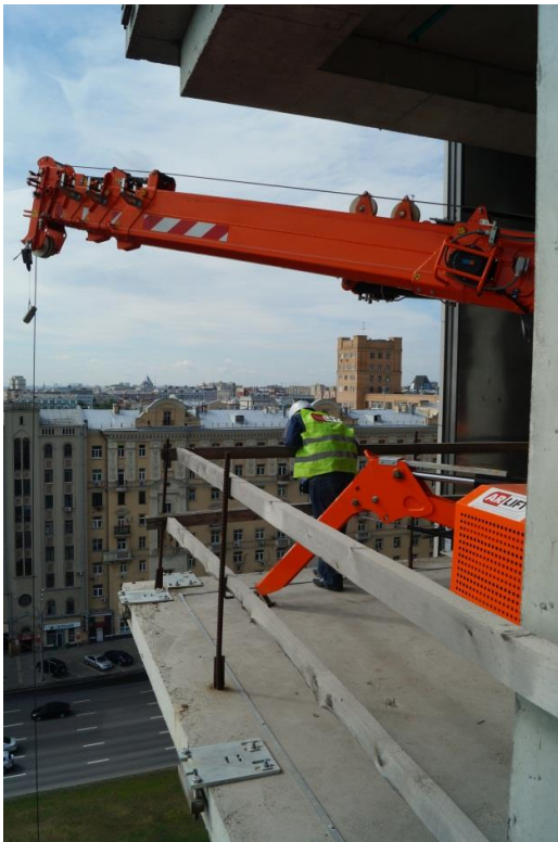
Слика 32. Подизање и монтажа угаоних фасадних панела са 14. спрата зграде
