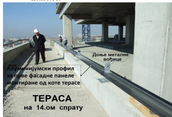
Слика 6. Алуминијумски профил почетни за ношење фасадних панела
