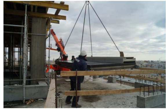
Слика 27. Веома тесни услови за монтажу, а тежина фасадног панела износи око 600 kg
