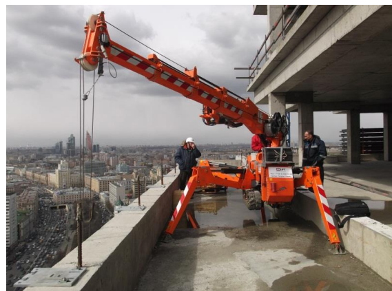
Слика 24. Припрема за рад малог гусеничног крана
