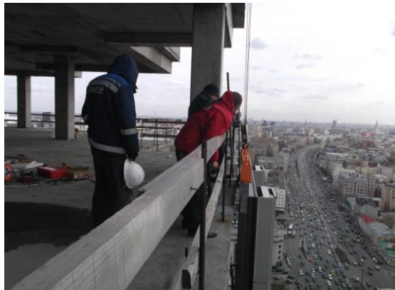
Слика 26. Монтажа фасадног панела малим гусеничним краном
