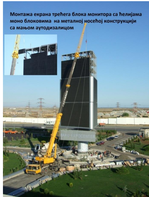
Слика 30. Подизање и монтажа мониторских ћелија - трећег монитора
