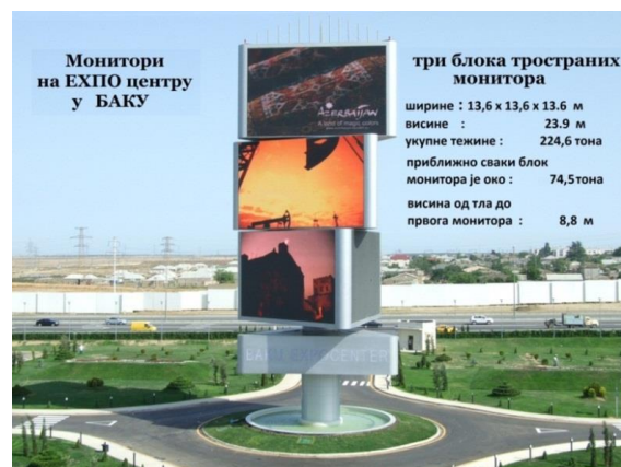
Слика 4. Окретни тространо призматични, тростепени блокови монитора - сваки је под одређеним углом заокренут у односу на други
