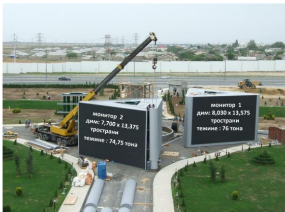
Слика 19. Монтажа крајњих лукова – штитника на монитору
