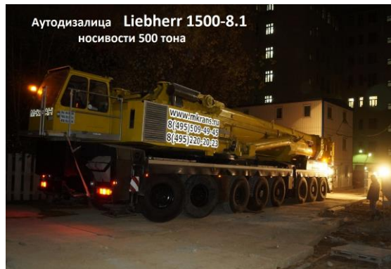
Слика 8.1. Превоз аутодизалице од 500 тона Liebherr LTM1500-8.1 током ноћи
