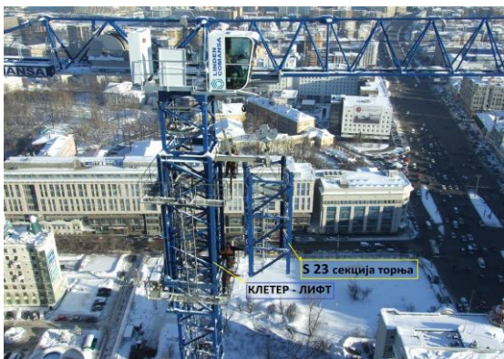
Слика 10. Торањски кран COMANSA 16 LC 185 (клетер и секција извађена из торња крана)
