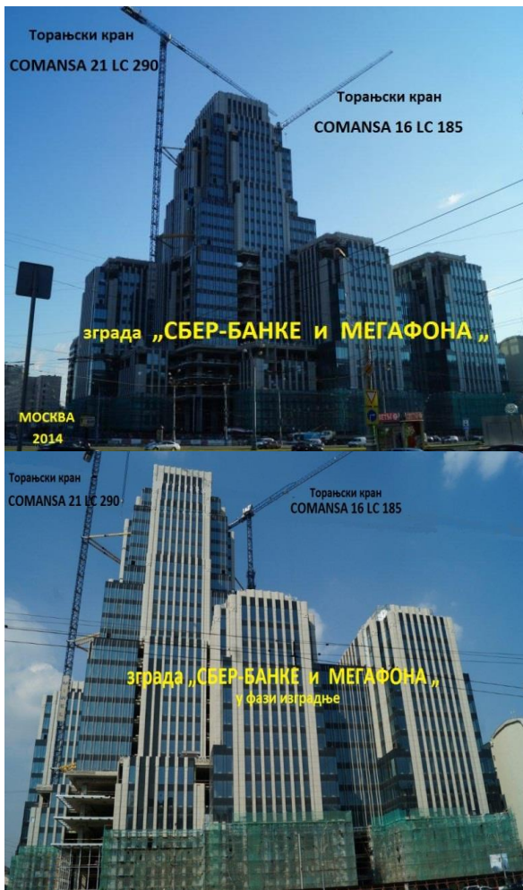
Слика 1. Положај торањских кранова при завршетку градње
