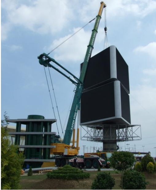
Слика 25. Завршни процес монтаже другог монитора – са навођењем
