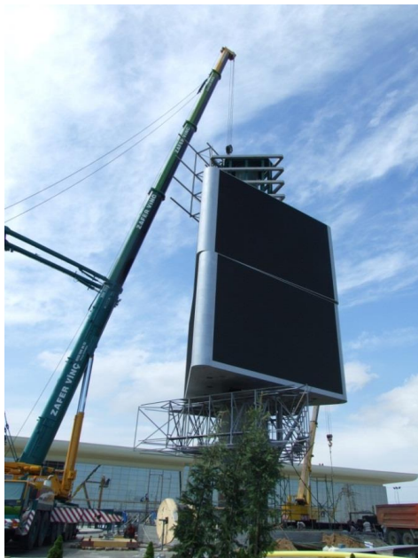
Слика 29. Подизање и монтажа носеће решеткасте челичне конструкције трећег монитора
