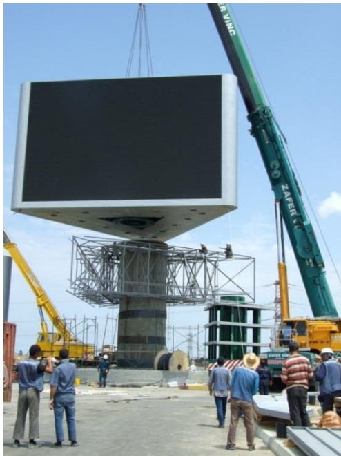
Слика 21. Подизање првог монитора са великом аутодизалицом од 350 тона
