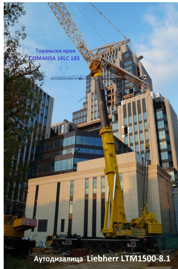
Слика 13. Аутодизалица од 500 тона Liebherr LTM1500-8.1 демонтажа торањског крана
