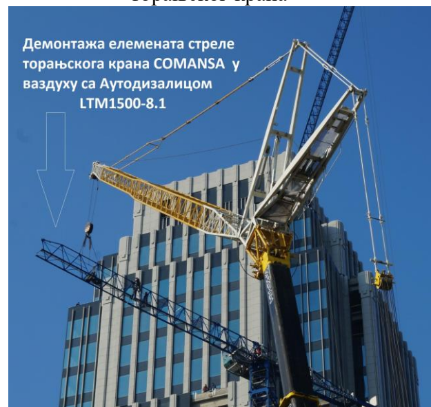
Слика 13.1. Аутодизалица од 500 тона Liebherr LTM1500-8.1 демонтажа торањског крана
