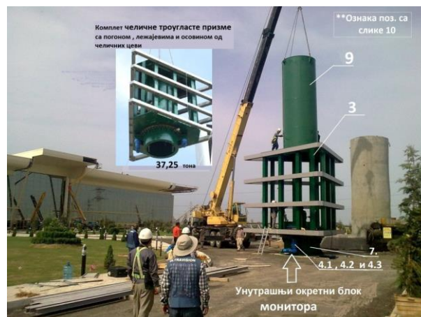
Слика 14. Монтажа носеће конструкције са погонским блоком (позиције су усвојене са слике 10)
