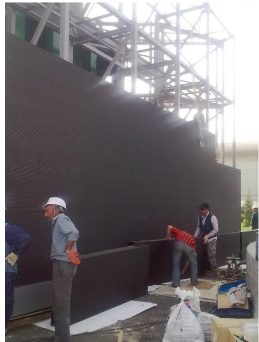
Слика 17. Монтажа ћелија моно блокова монитора – формирање монитора на носећој конструкцији
