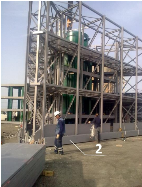
Слика 15. Челична носећа платформа са конструкцијом за ћелије монитора
