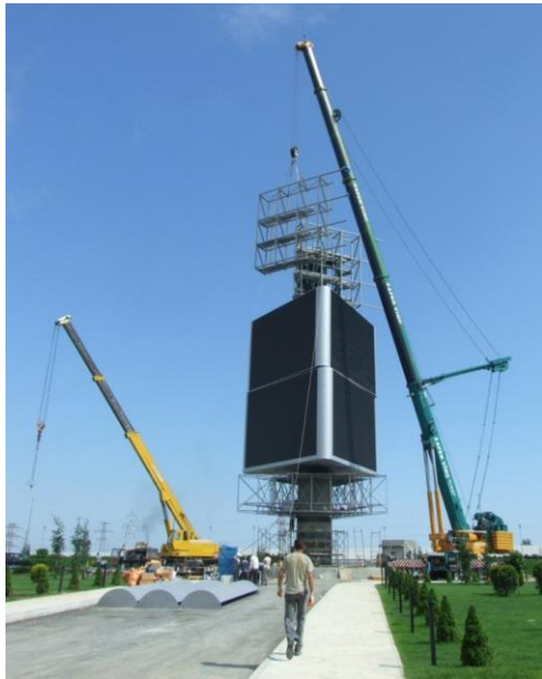
Слика 28. Подизање и монтажа носеће решеткасте челичне конструкције трећег монитора
