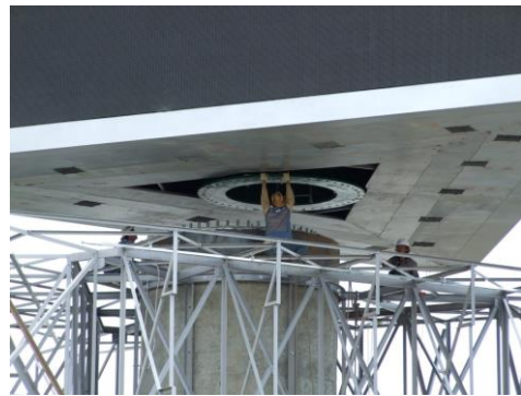
Слика 23. Монтажа првог монитора - његово прецизно навођење
