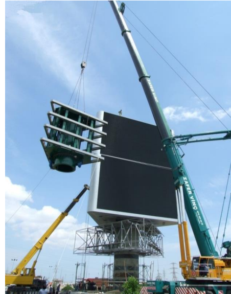
Слика 26. Подизање и монтажа носеће конструкције са погонским блоком трећег монитора
