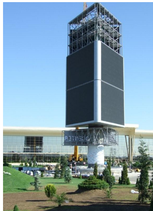
Слика 31. Подизање и монтажа мониторских ћелија - трећег монитора
