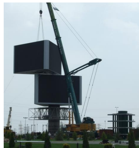
Слика 24. Монтажа другог монитора – са навођењем
