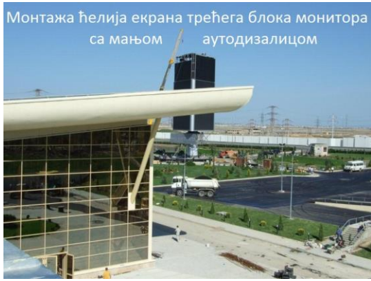
Слика 32. Подизање и монтажа мониторских ћелија моно блокова – трећег екрана монитора
