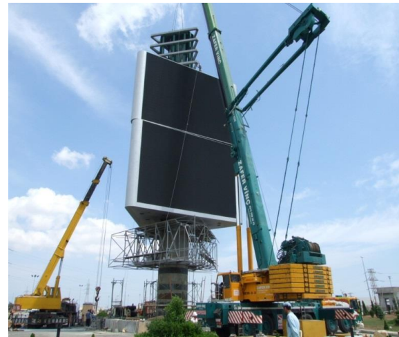
Слика 27. Завршна операција подизања и монтаже носеће конструкције са погонским блоком трећег монитора
