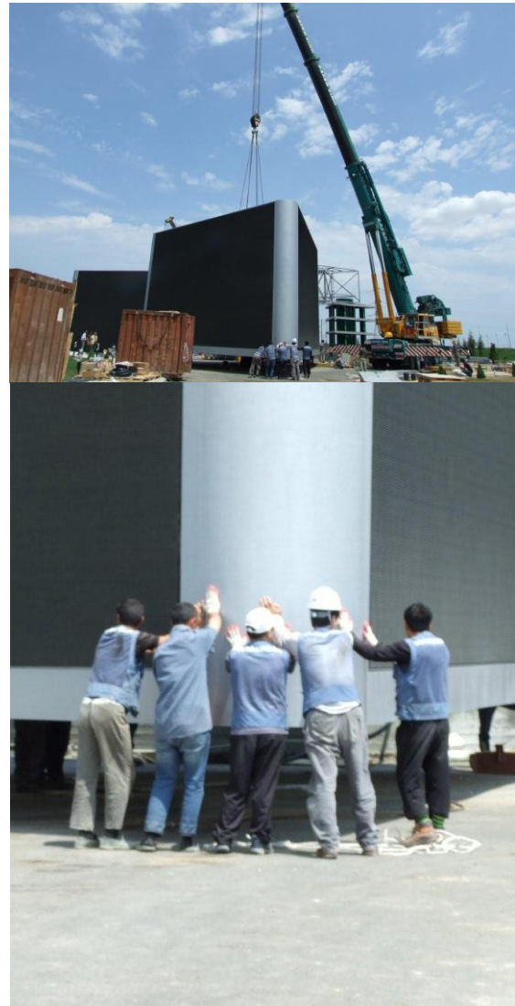
Слика 20. Припрема за подизање првог монитора са великом аутодизалицом од 350 тона
