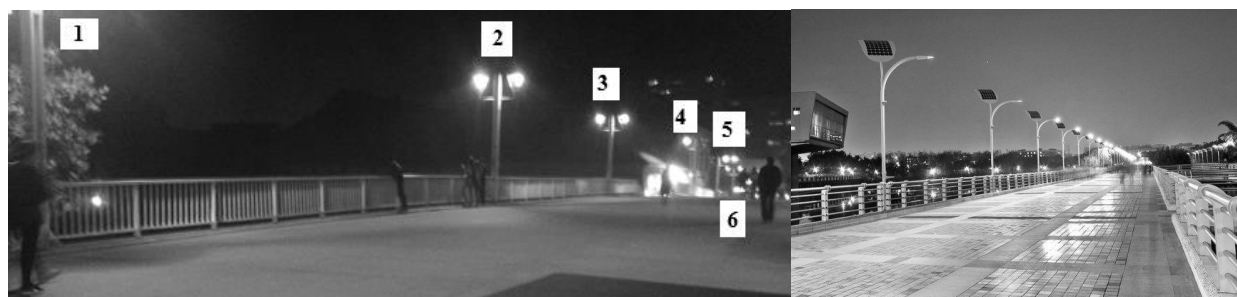
Slika 2. a-stub javne rasvete sa led svetiljkama leve strane mosta, b-stubovi sa svetiljkama sa solarnim panelima
