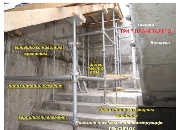
Слика 16. Елементи металне носеће конструкције PSK-CUPLOK са приказом хоризонталне повезаности у један компактни систем [2]
