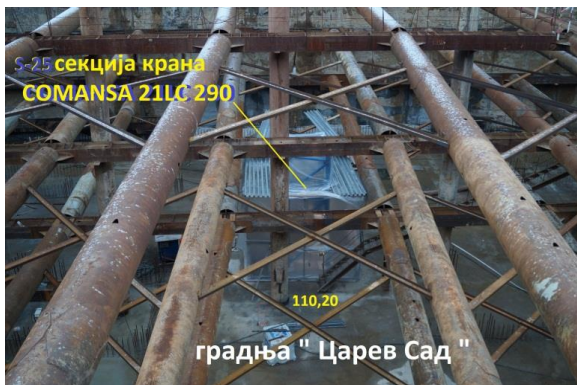
Слика 10. Место монтаже крана LINDEN COMANSA 21 LC 290 види се секција крана и простор за рад заштићен од мрза и ниских температура између распорног система [4]
