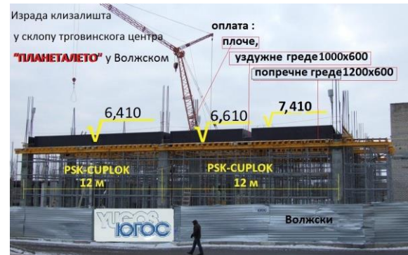
Слика 7. Поглед са задње стране клизалишта са висинама металне носеће конструкције PSK-CUPLOK [2]
