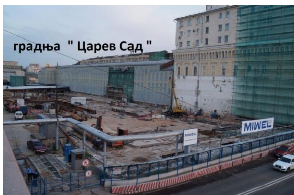
Слика 2. Градилиште „Царев Сад“ поглед са стране Кремља [4]
