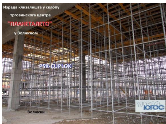
Слика 10. Поглед одоздо на металну конструкцију оплата греда и плоче [2]
