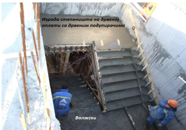
Слика 15. Израде степеништа са оплатама од дрвета, са дрвеним и металним подупирачима [2]
