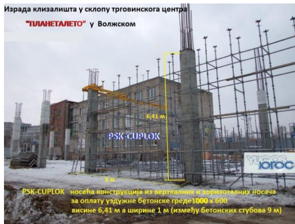
Слика 5. Носећа метална конструкција PSK-CUPLOK висине 6,41m са 5 реда хоризонтала [2]
