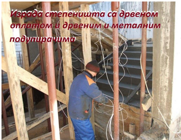
Слика 14. Дрвена оплата степеништа на носећој конструкцији састављена из дрвених и металних подупирача [2]
