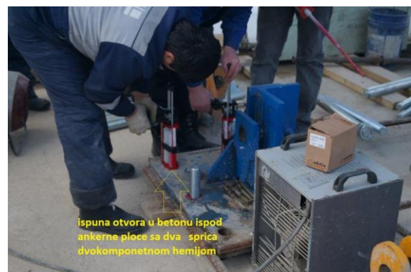
Слика 12. Наношење односно убризгавање двокомпонентног лепка МКТ VME помоћу специјалних пиштоља у избушене отворе у бетонском темељу [4]
