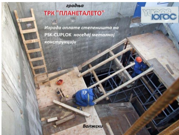
Слика 17. Израда оплате степеништа на носећој металној конструкцији PSK-CUPLOK [2]
