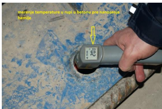
Слика 11. Мерење температуре у избушеном отвору у бетону пре наношења хемије [4]
