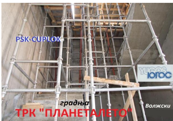
Слика 18. Повезивања металне конструкције PSK-CUPLOK, три и више реда вертикалних носача са хоризонталним елементима са усаглашеним висинама као скела за оплату степеништа [2]
