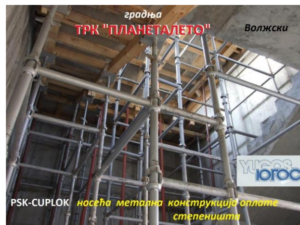
Слика 19. Израда сложене носеће металне конструкције PSK-CUPLOK за пети спрат троструког степеништа објекта са три реда и међуредом [2]
