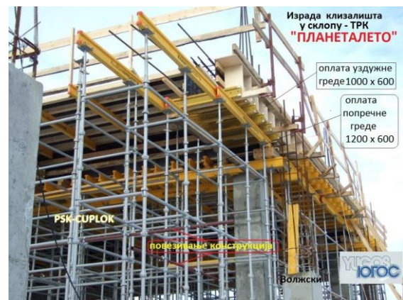
Слика 9. Поглед са чеља и приказ међусобног повезивања скупина носеће металне конструкције са цевима \varnothing 48 [2]
