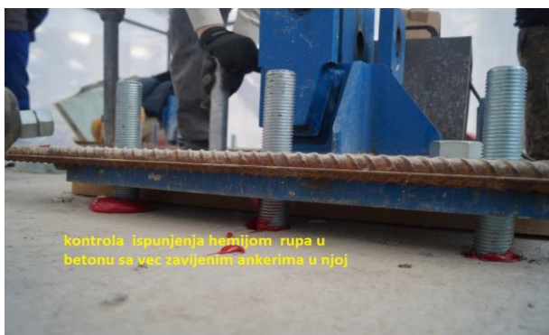
Слика 14. Контрола наношења лепка визуелно и контрола анкерног завртња [4]
