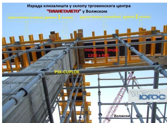
Слика 6. Метална носећа конструкција PSK-CUPLOK висине 6410mm за оплату попречних греда [2]
