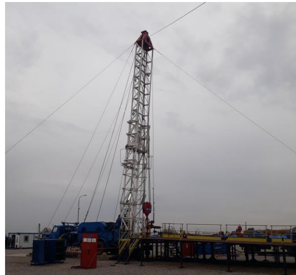
Слика 4. Ремонтни торањ из 1959. год.
